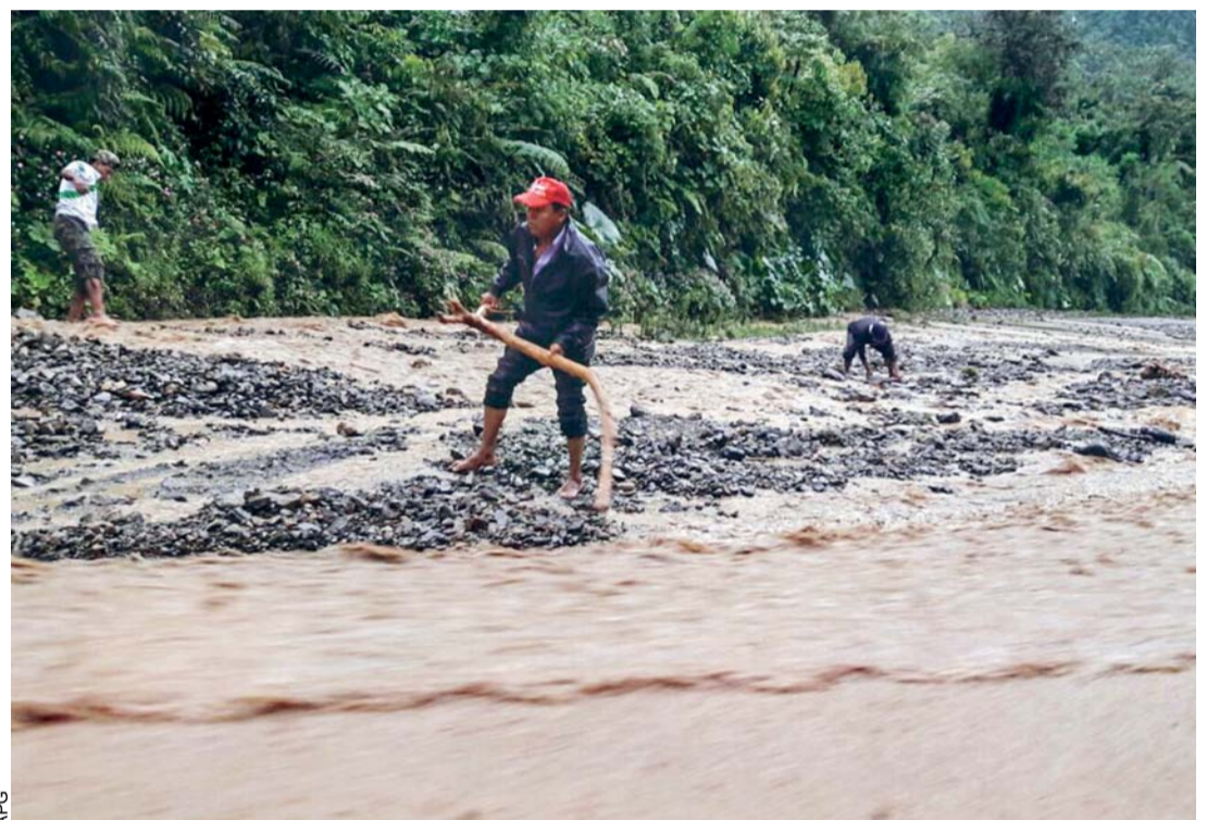
LA CARRETERA NUEVA ENTRE COCHABAMBA Y SANTA CRUZ FUE CERRADA POR DERRUMBES REGISTRADOS EN LOS KILÓMETROS 110 Y 120 DE LA ZONA DE EL SILLAR, COMO CONSECUENCIA DE LAS PERSISTENTES LLUVIAS DE LOS ÚLTIMOS DÍAS.
